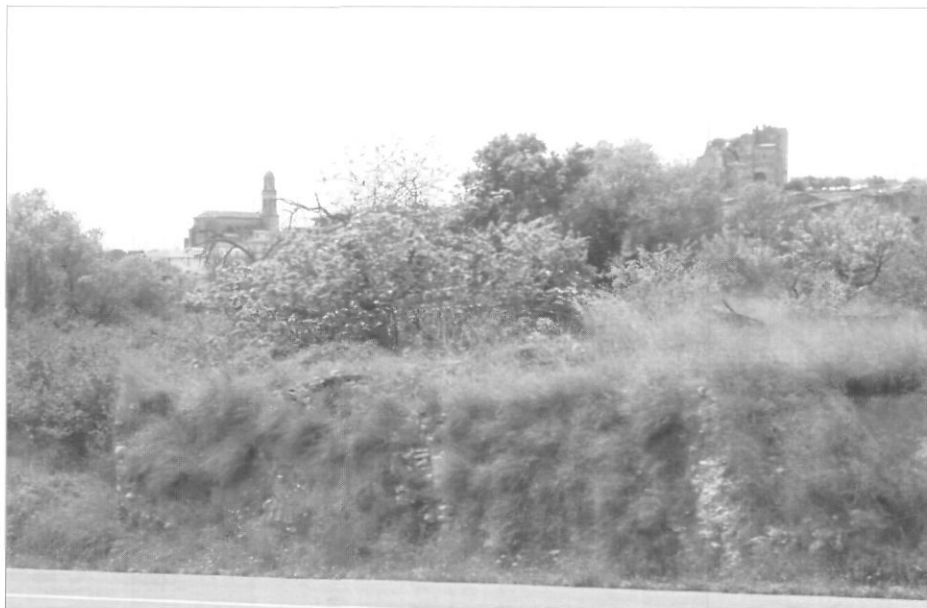
Figura 4. Vista del talús occidental de la variant de passada pel jaciment. S'hi poden apreciar tres murs afectats
