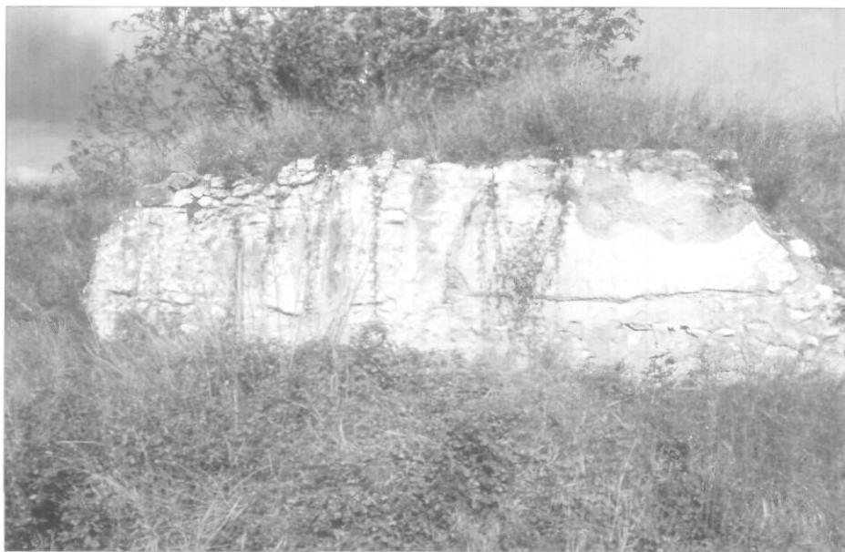
Figura 5. Detall d'un dels murs tallats, que actualment fa de marge, que encara conserva restes d'arrebossat
