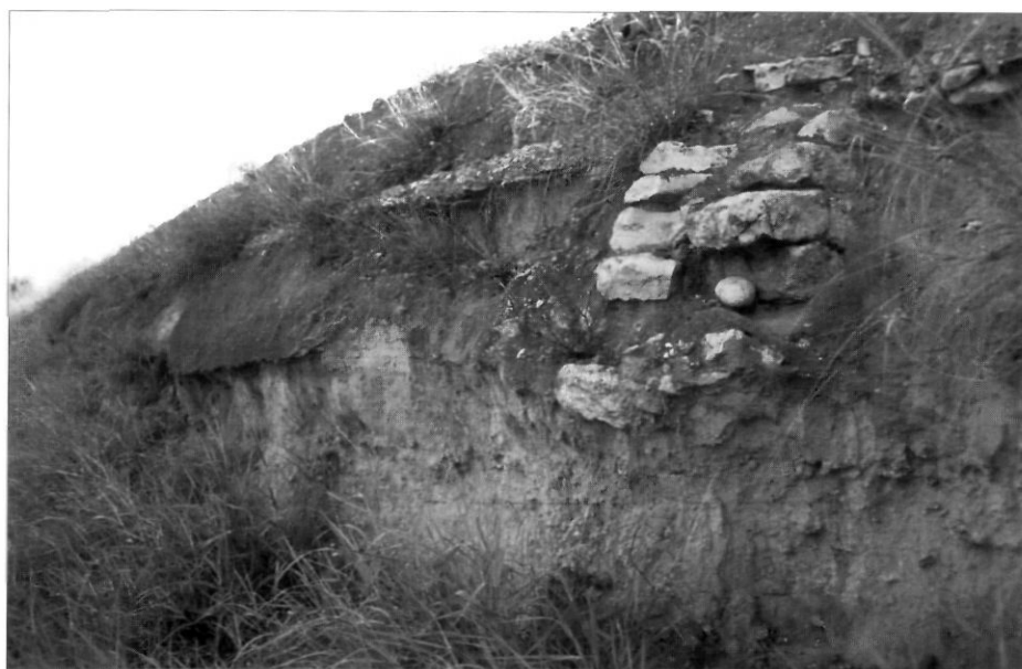
Figura 3. Detall d'un mur i un paviment en el qual es pot apreciar el procés de degradació
